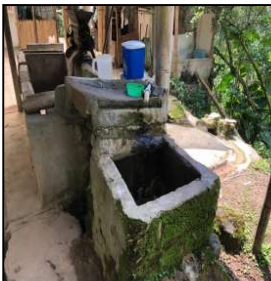
Fotografía 5, 6, 7 y 8. Tanques almacenamiento del recurso y elementos de control del mismo para uso doméstica en la vivienda dentro del predio rural denominado "Lote número Uno".
