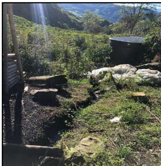
Fotografías 5, 6, 7, 8 y 9: conducción y punto de descarga aguas residuales no domesticas dentro del predio, vereda Los Olivos -Pital-Huila
