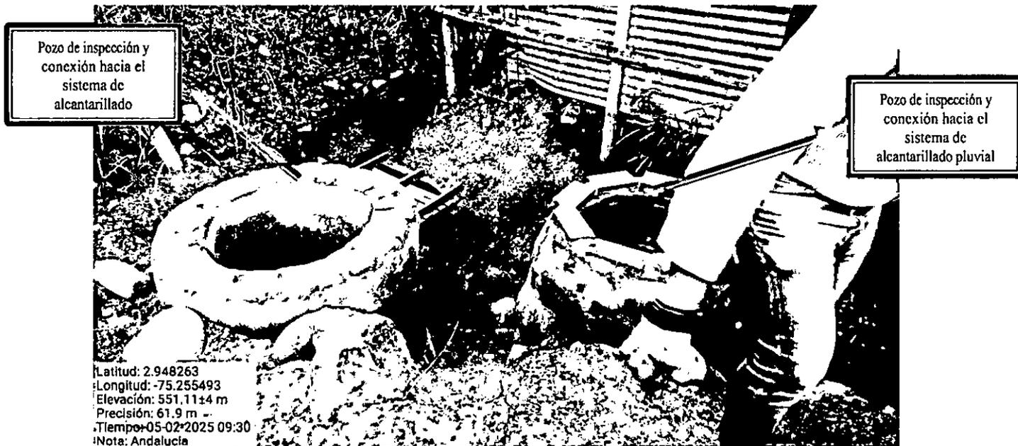
**Foto No. 10.** Evidencia fotográfica de los pozos de inspección de alcantarillado pluvial y sanitario del Proyecto Los Cedros de la Constructora Andalucía Diseño y Construcciones S.A.S.
