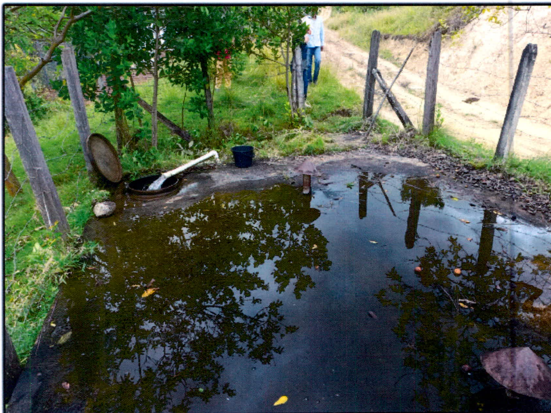
Fotografía No. 5: Estructura de obra civil de concreto reforzado que cumple la función de tanque de almacenamiento ( 2^{\circ} 28' 35.48'' N y 75^{\circ} 28' 18.03'' W).
