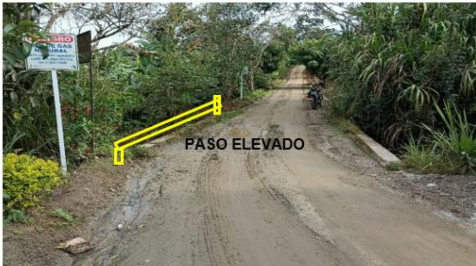
Fotografía 1, 2 y 3. Panorámica sitio de intervención proyectada sobre la Quebrada La Chiquita.
