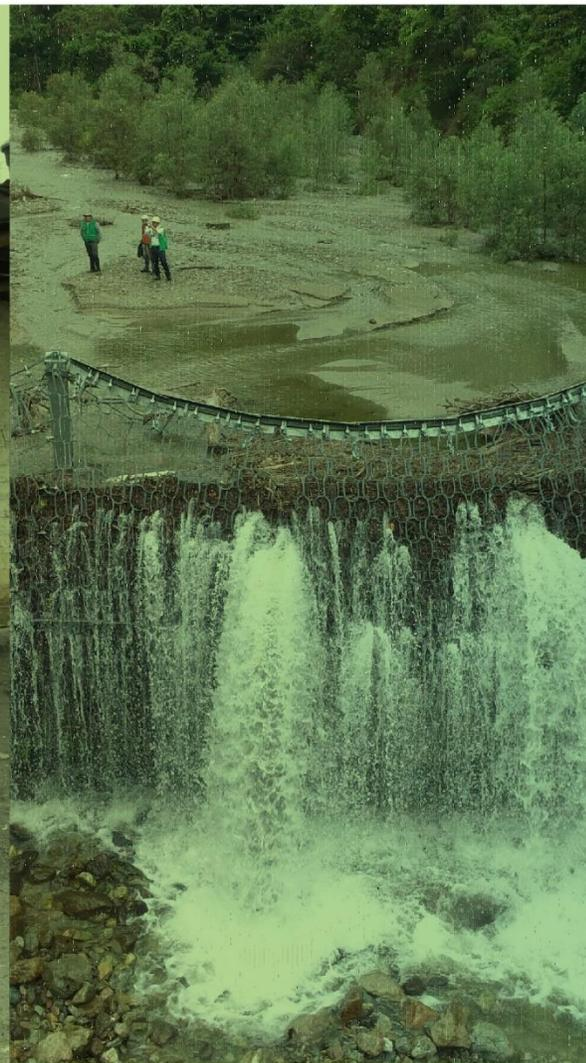
Para la gestión de riesgo de desastres en la cuenca del río Las Ceibas de Neiva, se inició la construcción de una nueva barrera dinámica sobre el cauce de la quebrada los micos, para completar un total de **4 mallas instaladas**. Se actualizó el sistema de transmisión de la Red de Alertas tempranas.
