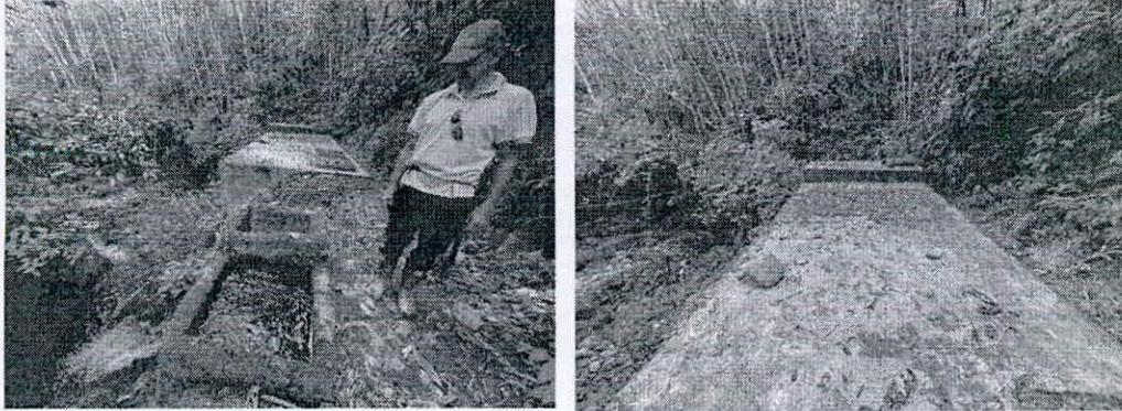
Imagen 6 y 7. Estructura de desarenador y tanque de almacenamiento.
