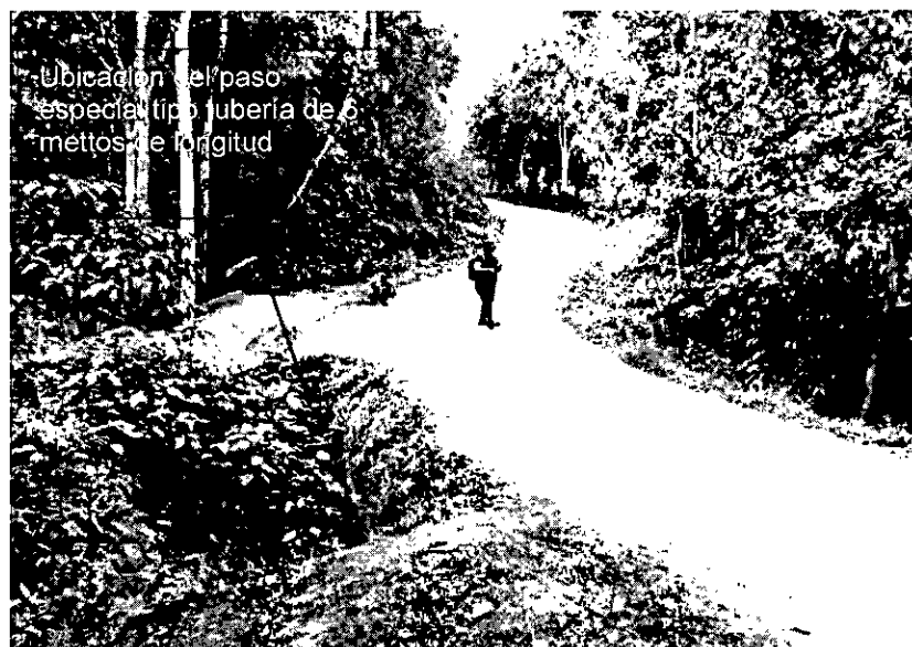
Foto No.1. Zona de intervención en donde se construirá el paso tipo Cercha para el paso especial tipo tubo en la margen izquierda.
