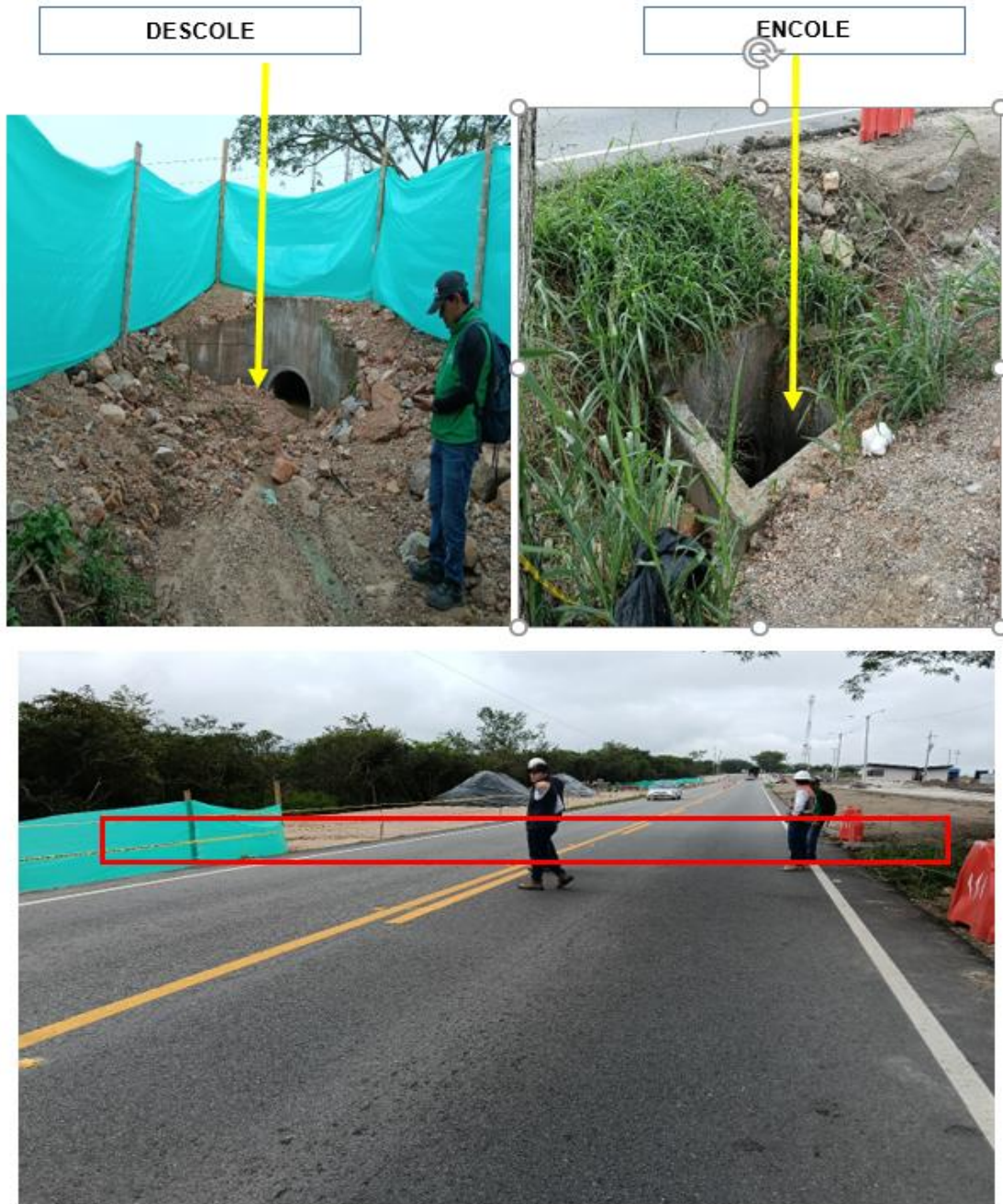
Fotografía 1, 2 y 3. Obra hidráulica existente UF4-83 ubicada en la abscisa de diseño K57+390.
