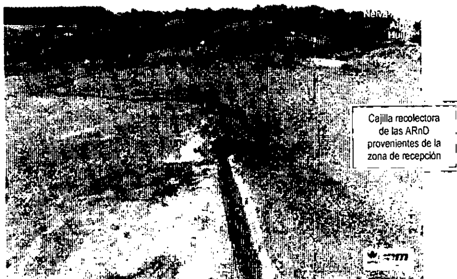
Fotos 12 y 13. Evidencia fotográfica de las cajillas perimetrales que se ubican en la zona de recepción de la materia prima y de la cajilla recolectora de las ARnD generadas en la empresa Masedaga S.A.
