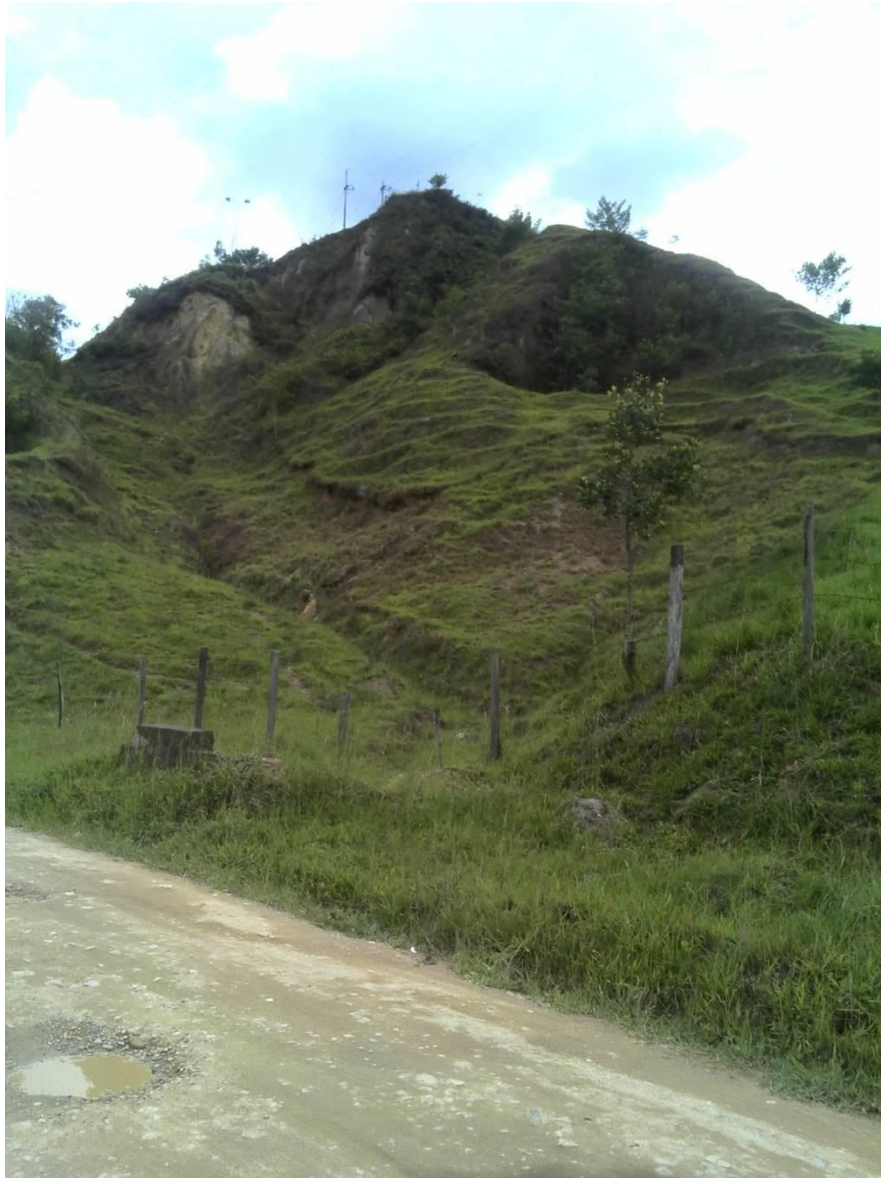
Foto 134. Taludes fallados por actividad tectónica local
