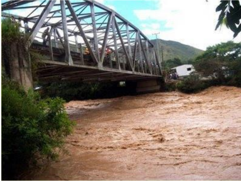
Foto 138. Foto de creciente en el puente del río Suaza, municipio de Acevedo.
