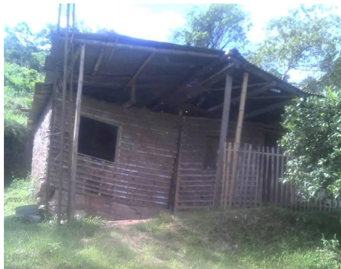
Foto 126. Casa afectada por taludes inestables en zona de falla
