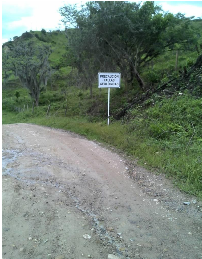
Foto 133. Deslizamientos en la zona de Acevedo por efectos del fallamiento regional.
