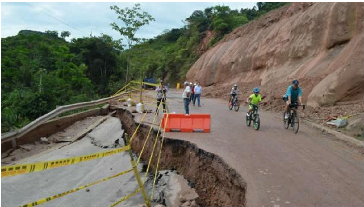
Foto 141. Pérdida de bancada por inestabilidad de terreno municipio de Suaza. Fuente Optinoticias.
