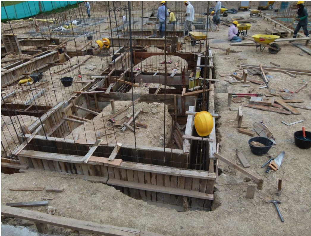
Foto 142. Construcción de Ciudadela El Porvenir municipio de Suaza. Fuente Alcaldía Municipal
