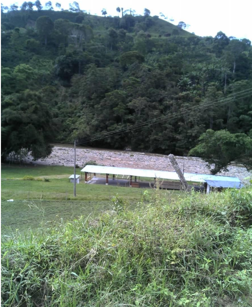
Foto 131. Potrerización y construcción en zona de inundación.
