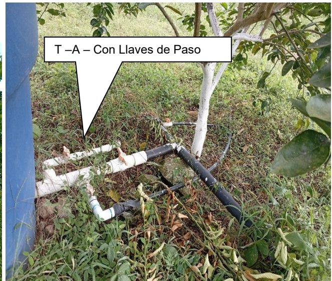
Fotografías N° 7,8 Tanque de almacenamiento y distribución – Llaves de paso para regulación del R.H.
