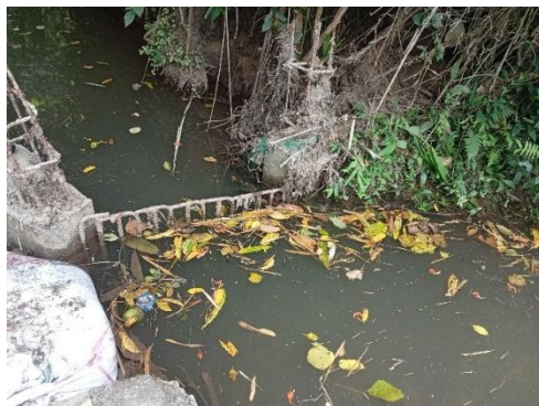
Fotografías N° 2,3 Canal inicial y rejilla con obstrucción
