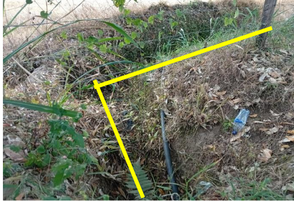
Fotografía N°5 Reservorio – Estanque en tierra
