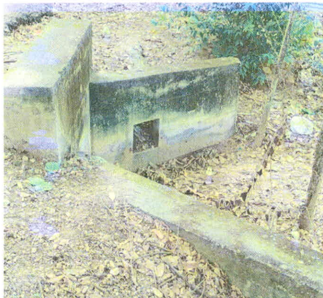
Imagen 23. Box culvert calle 51 para agua lluvias sobre drenajes intermitentes naturales.
