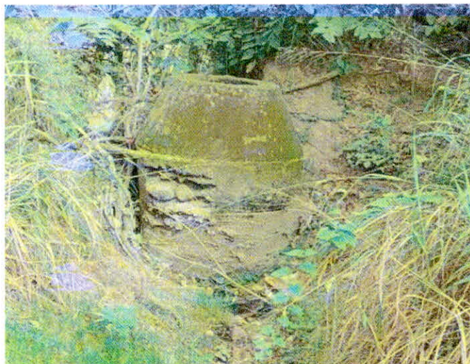
Imagen 18. Cámara de inspección calle 51 con carrera 32. Colilla recolección de aguas lluvias. Fuente: DAA, presentado 2026
