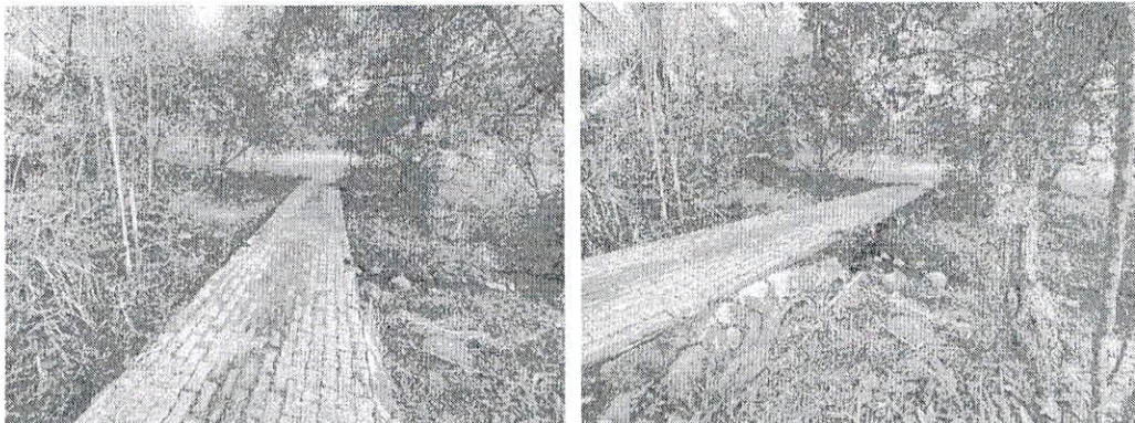
Foto 1 y 2. Puente peatonal existente.
