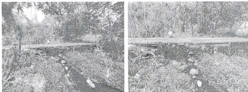
Foto 3 y 4. Vista lateral del puente sobre el paso de la quebrada Matamundo.
