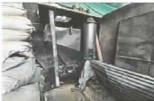
Fotografía 5 y 6. Área de ingreso del combustible, tolva de almacenamiento del combustible, cuenta con sinfín que ingresa el sisco hasta el área de combustión
