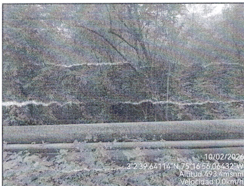
Foto 2. Punto del cruce P5 de intervención en donde se instalaría la línea de flujo aérea. Fuente: Propia
