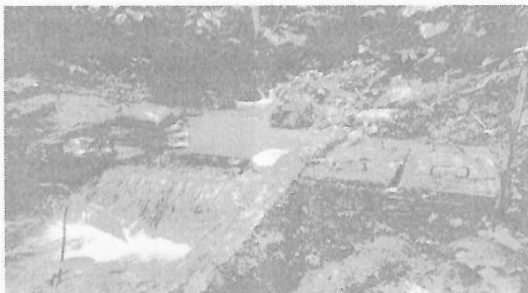
Fotografías 1: Obra de captación
