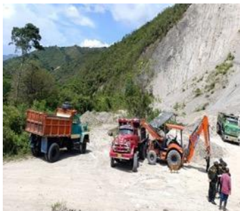
Operativo de Control a las afectaciones ambientales por minería ilegal de material de cantera vereda el Puente de Altamira.
