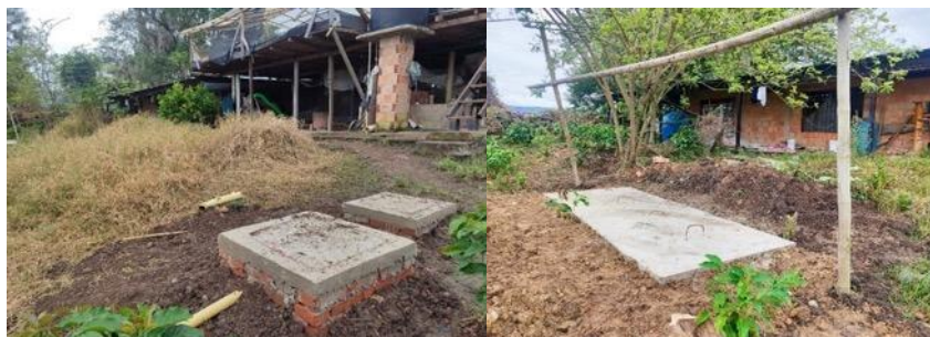
Pozos sépticos instalados en la vereda San Vicente del municipio de Elías
