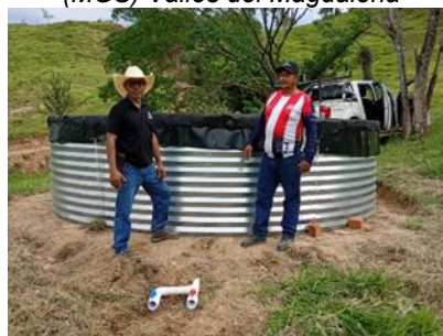
Tanque Australiano, Beneficiario Liborio Polanco vereda La Floresta Municipio de Yaguará
