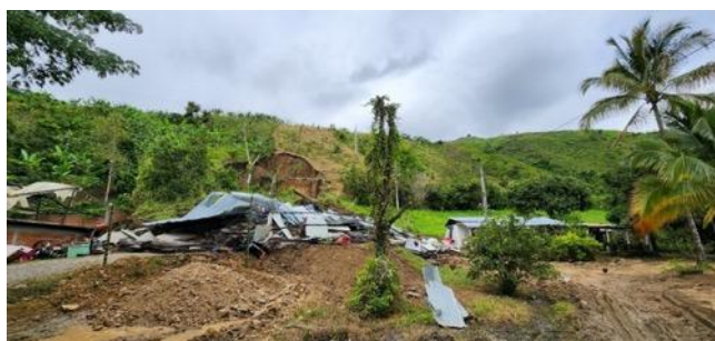
Asistencia técnica Municipio de Guadalupe, vereda La Planta por inundación
