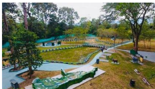
Construcción Sendero de Interpretación Ambiental – Sede Pitalito
