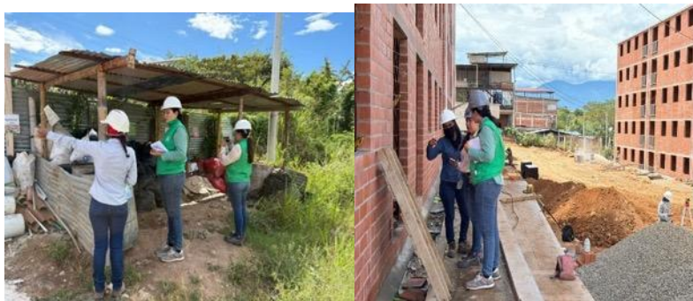
Visita de control y seguimiento a Grandes generadores de RCD en el Municipio de Neiva.
