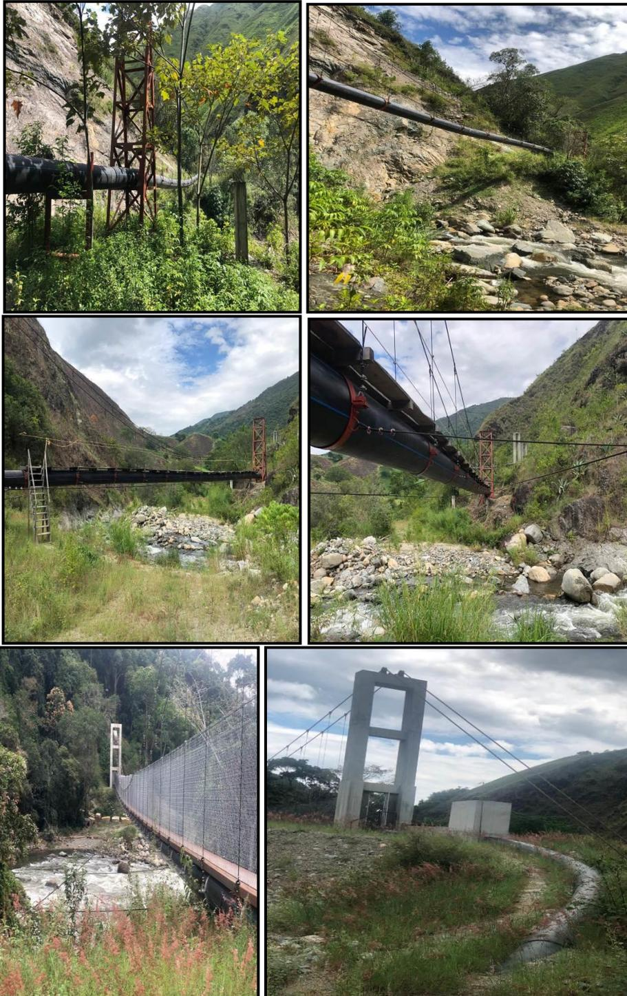
**Fotografías 10 al 15:** Obras hidráulicas viaductos sobre Quebrada la Pescada y Rio Suaza.
